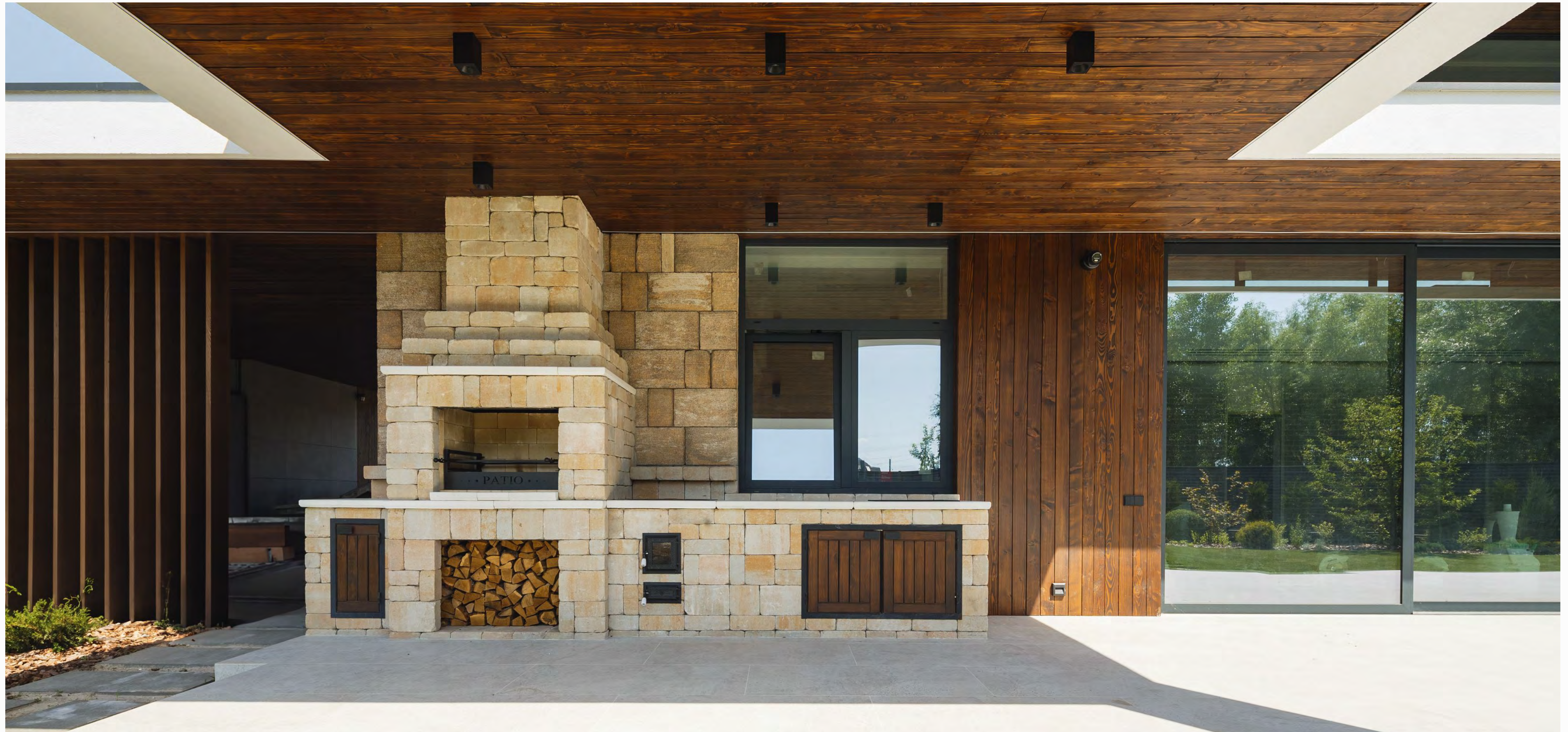
Барбекю зона Grimov в кольорі Бланко, облювальний камінь Неаполь в кольорі Терра
